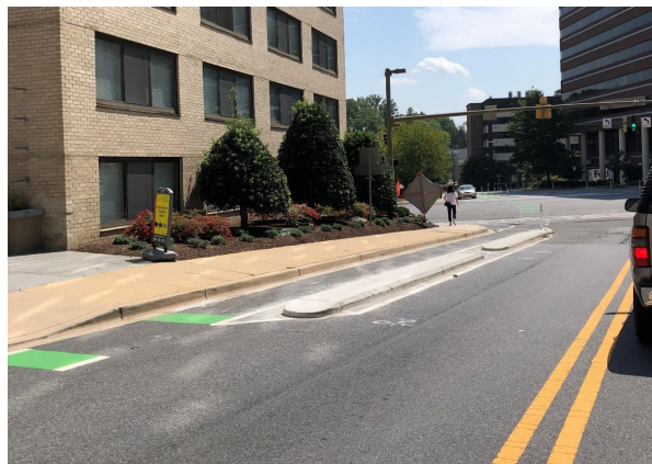
Carriles para Bicicletas con Delimitación: Hormigón Prefabricado
