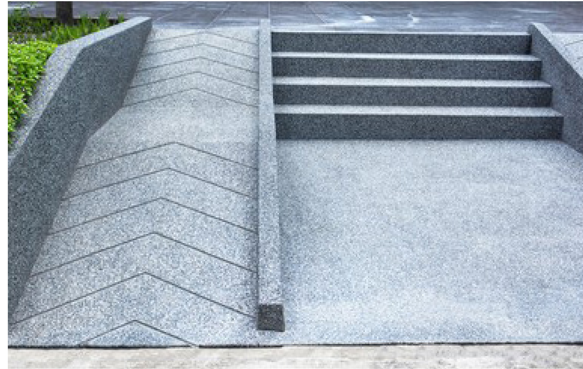
Rampa para Discapacitados con Escaleras Crédito: 123RF.com (Nota: todas las rampas y escaleras incluyen baranda)
