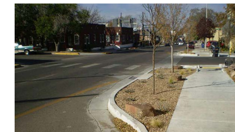
Extensión de Acera en la Intersección Image Credit: James Barrera
