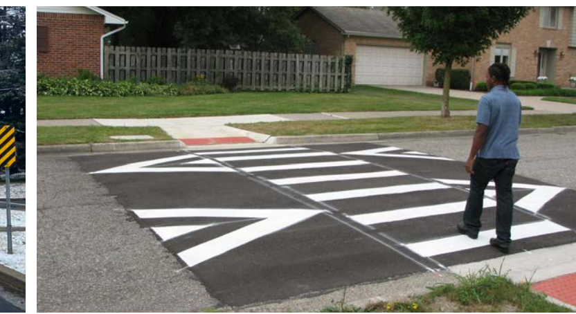
Cruce Elevado Crédito: City of Ann Arbor, MI
